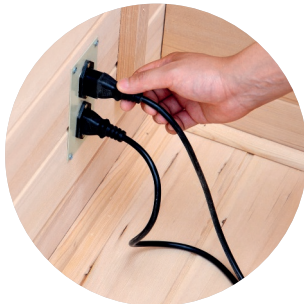
Zapojené káble ohrievačov
