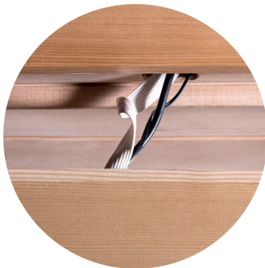
Ukázka protažení kabelů
