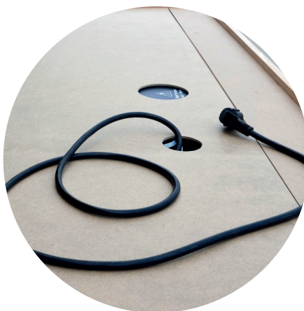
Inštalácia krytu stropu
